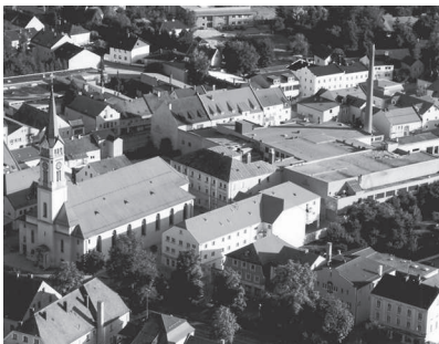
Stadtzentrum Plattling vor Abbruch der Fleischwarenfabrik (Foto: Stadt Plattling)
